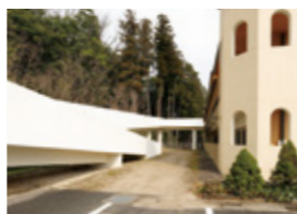
ナーシングホームシャレーにおいては、設計段階で幅員の広いスロープを設け、ご利用様が利用するベッドを使った避難を可能にしました。
